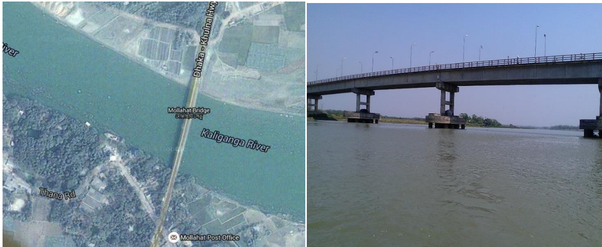
(d) Station 4: Mollar hat Bridge in Modhumoti River
